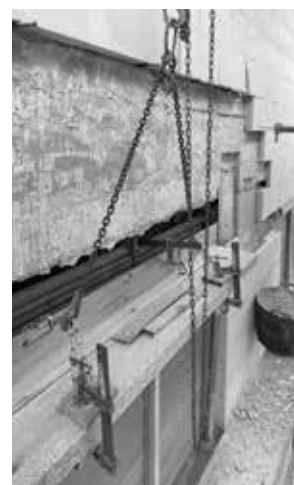
Proceso de fijación del aplacado y montaje de visera
