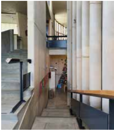
Escalera interior, acceso P1 a P2
