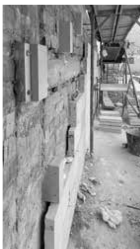
Proceso de fijación del aplacado y montaje de visera
