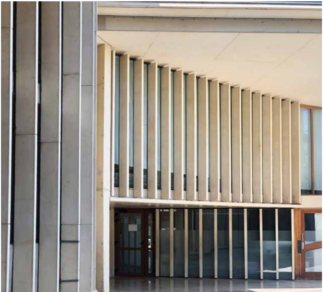
Acceso al patio exterior P1
