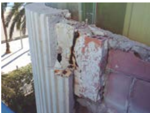
Fig 104. Demolición de aplacado irrecuperable
