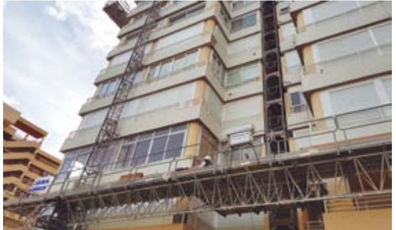
Fig 19. Vista general de andamios en fachada
