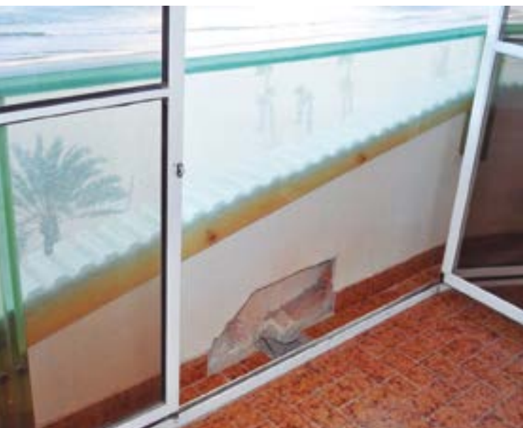
Fig 79. Modificación de sistema de evacuación de agua de lluvia en terraza
