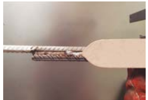
Fig 98. Limpieza a fondo con cepillo de acero
