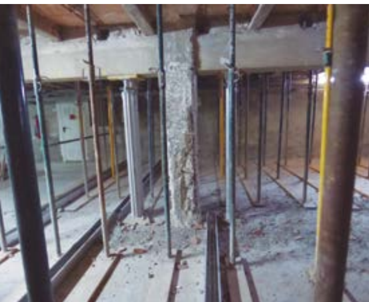
Fig 6. Ejemplo de pilar aislado objeto de reparación
