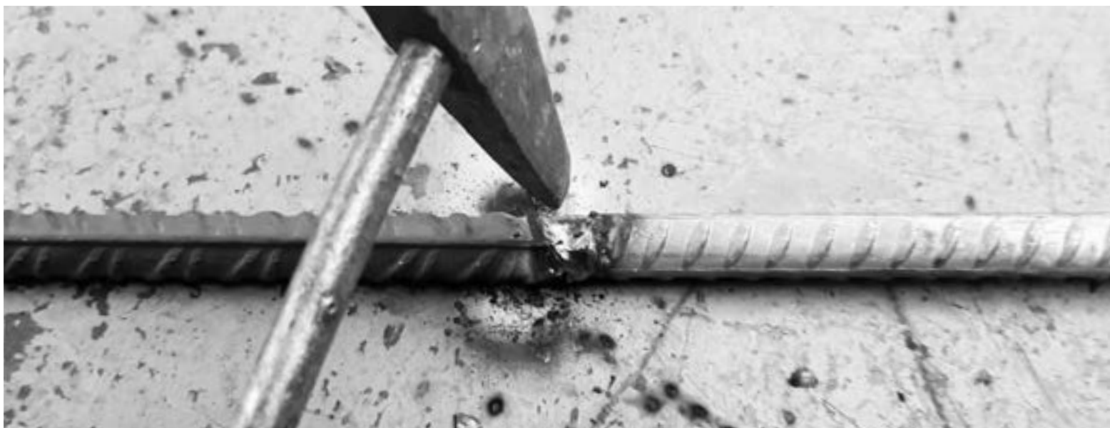
Fig 93 Limpieza de soldadura con piqueta
