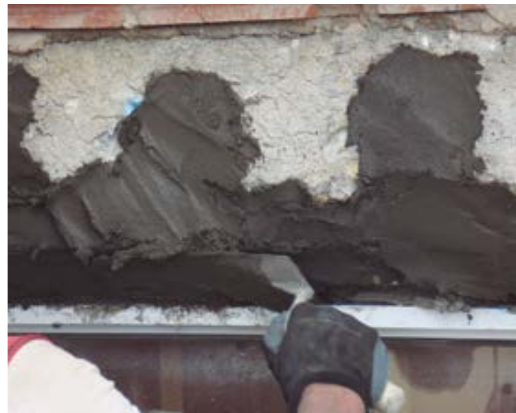
Fig 5. Reconstrucción de volúmenes con mortero de reparación
