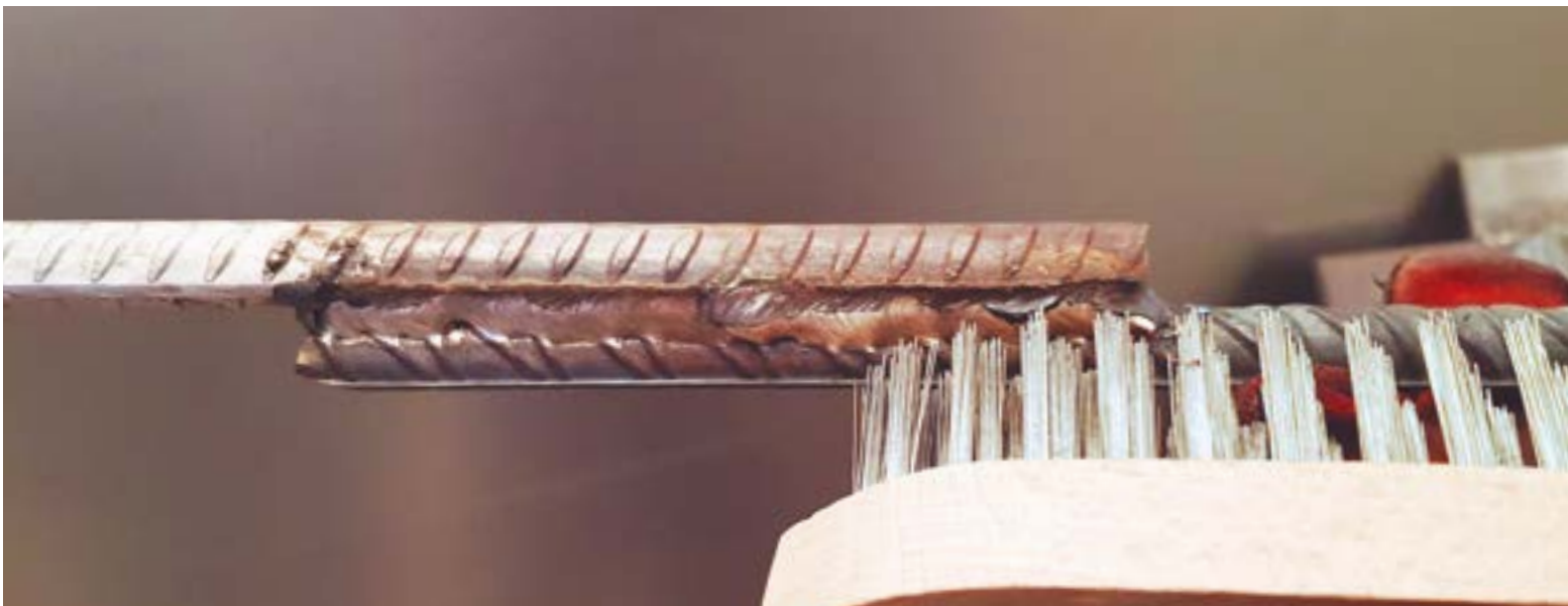
Fig 99. Soldadura tras la limpieza de las escorias
