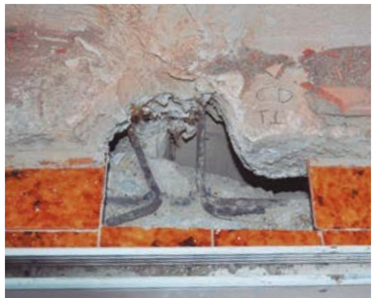
Fig 80. Detalle cata por el interior en anclaje de aplacados prefabricados
