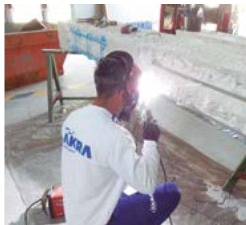
Fig 117. Realización de cordón de soldadura
