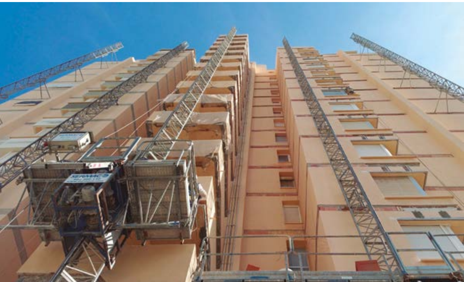
Fig 1. Vista general de reparación de frentes de forjado
