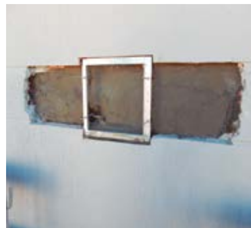
Fig 158. Registro de frente de forjado
