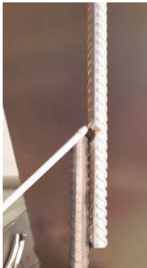
Fig 86. Detalle de ajuste de solape para soldadura
