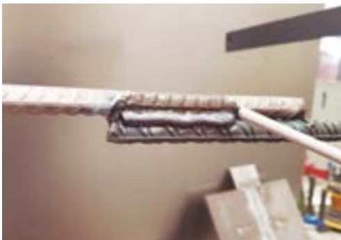
Fig 95. Realización de cordón recto de soldadura
