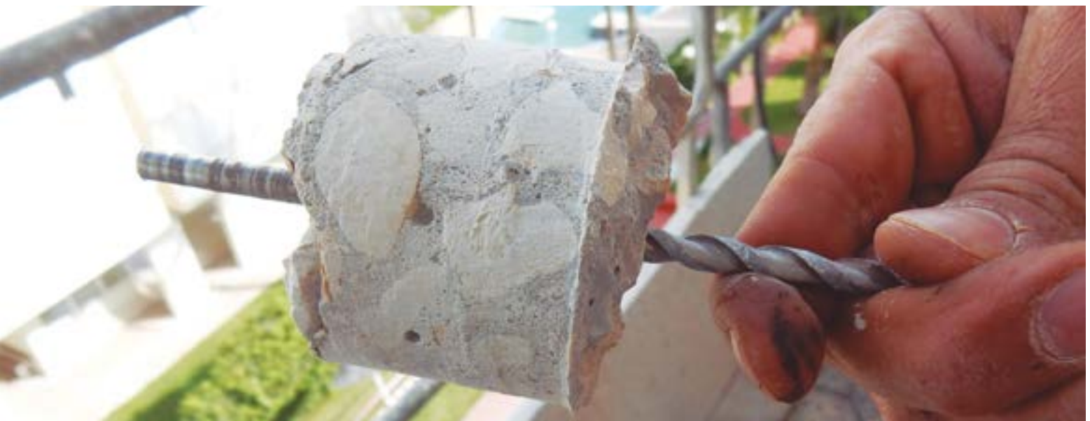
Fig 72. Detalle de testigo extraído de frente de forjado para ensayos en laboratorio
