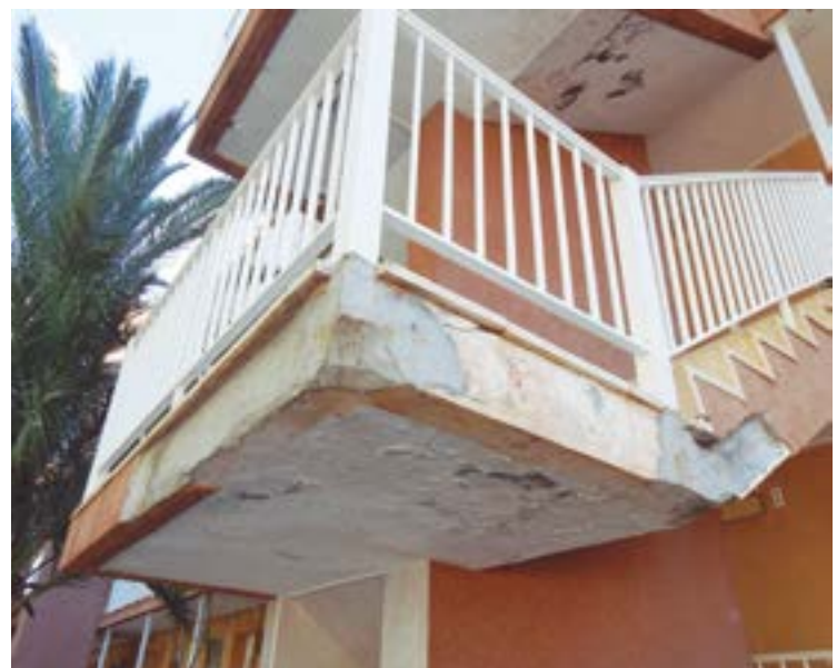
Fig 7. Losa de escalera exterior con anclajes de barandilla
