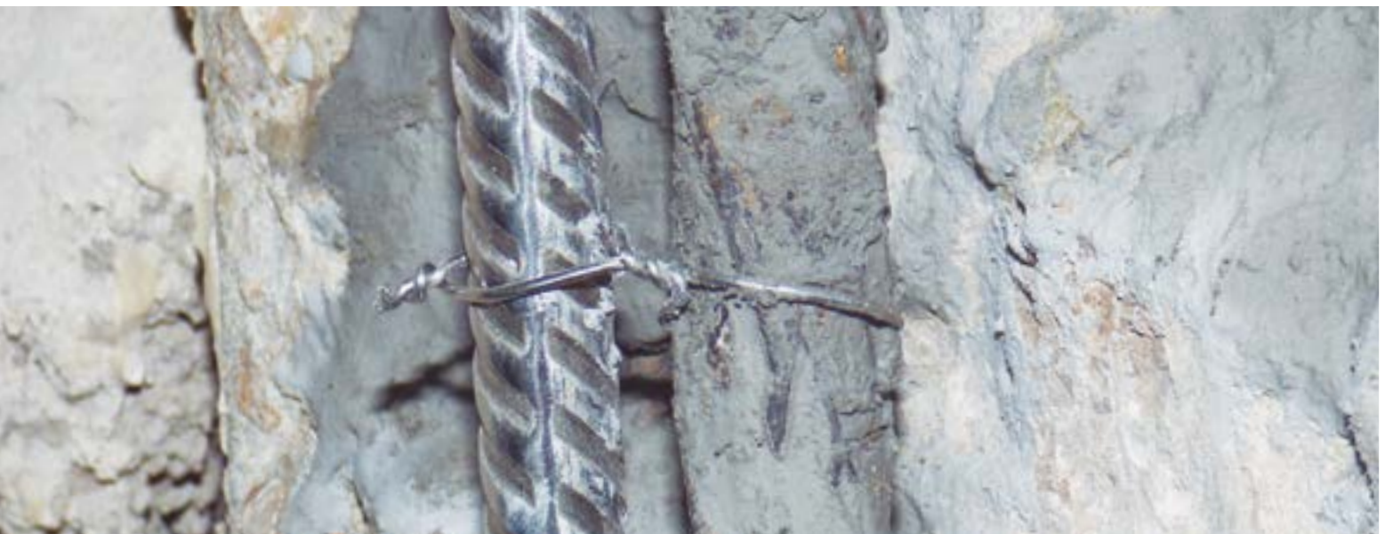
Fig 116. Atado con alambre de acero inoxidable para garantizar la separación entre la armadura existente (lijada y protegida) y la nueva
