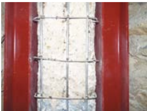
Fig 103. Sustitución de armadura por corrugado de INOX
