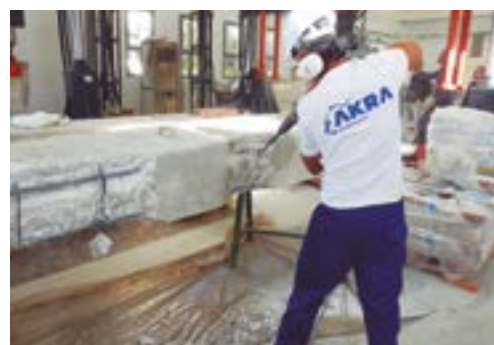
Fig 108 a. Picado de hormigón en taller
