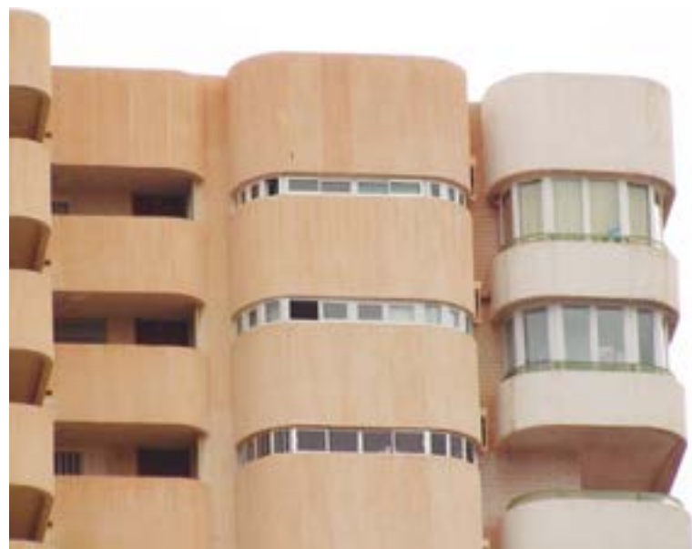
Fig 78. Detalle de fachada con aplacados de hormigón prefabricado
