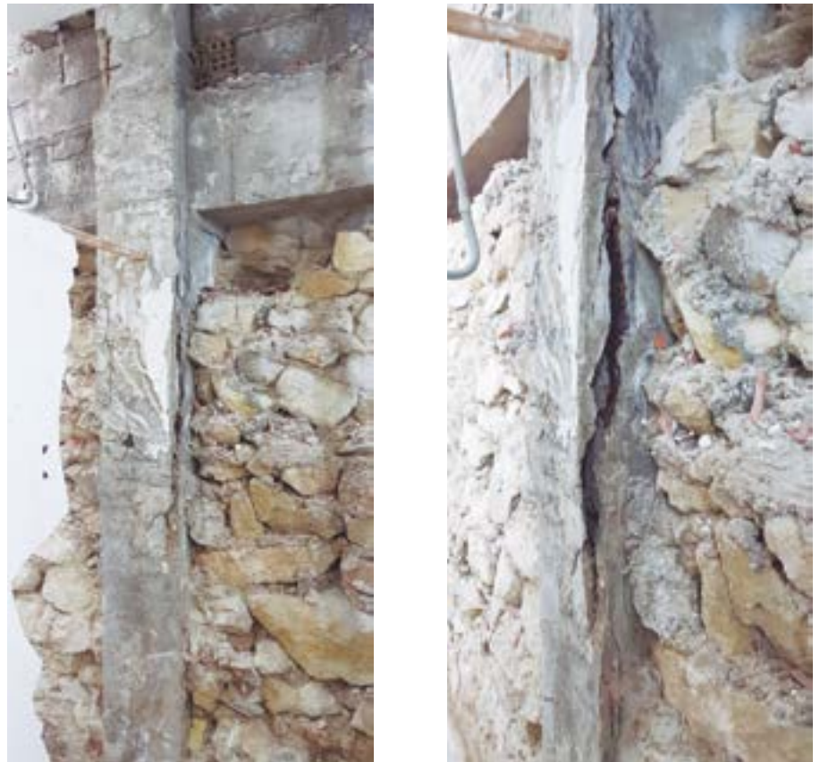
Fig 26. Vista 1 y 2 de pilar en planta sótano con alto riesgo de colapso
