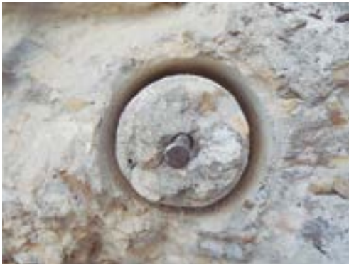
Fig 71. Testigo en frente de forjado
