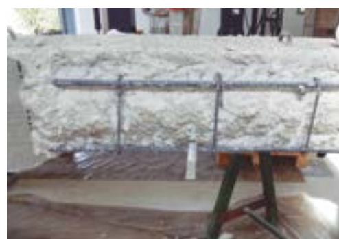
Fig 108 b. Tramo de picado de hormigón hasta dejar al descubierto las armaduras en todo su perímetro
