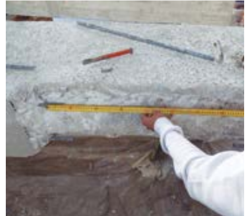
Fig 112. Fase de preparación en muestra de sustitución de armados para corrugado inoxidable
