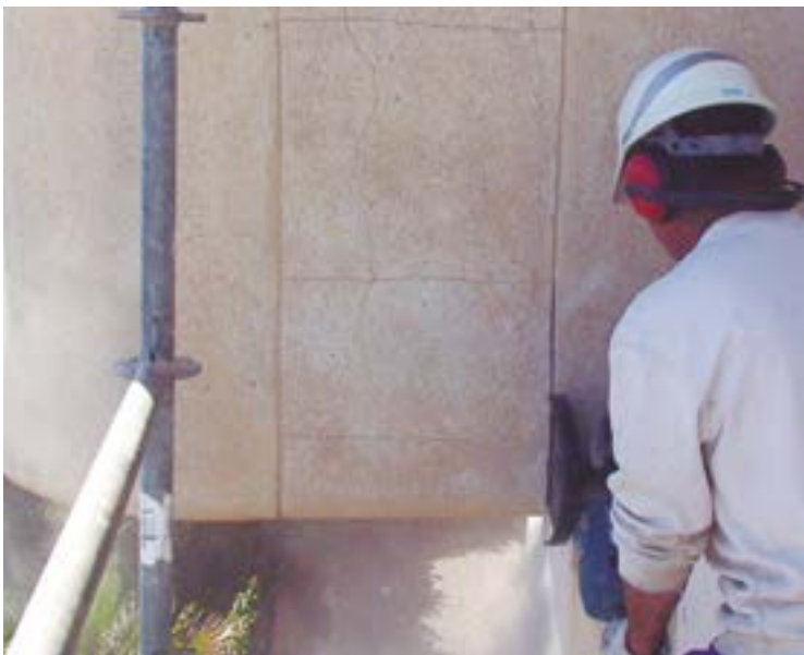
Fig 68. Realización de cajeados mediante medios mecánicos para observar elemento
