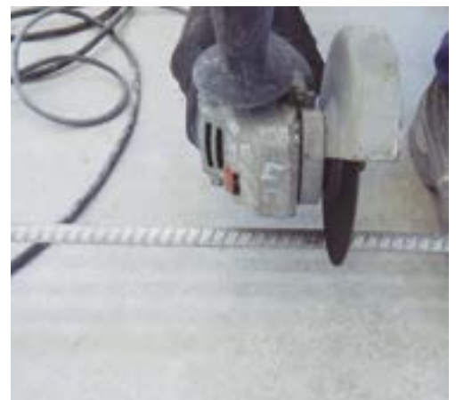
Fig 113. Proceso de corte in situ de longitud de barra deseada para la sustitución
