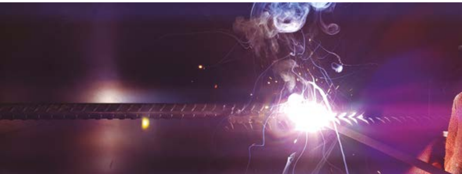
Fig 87 Realización de cordón de soldadura
