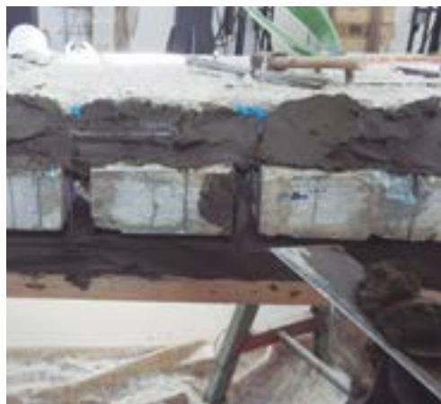
Fig 128. Proceso de reconstrucción de volúmenes con mortero de reparación
