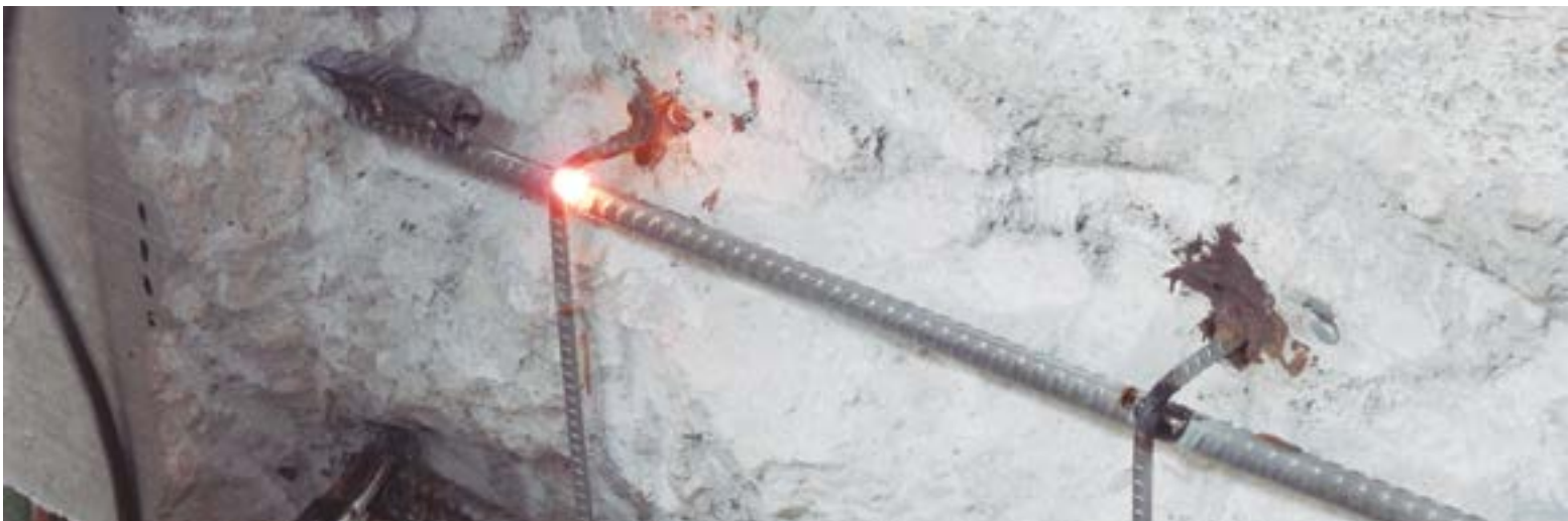
Fig 124. Punteado por soldadura de elementos de estriado de corrugado inoxidable a barras principales
