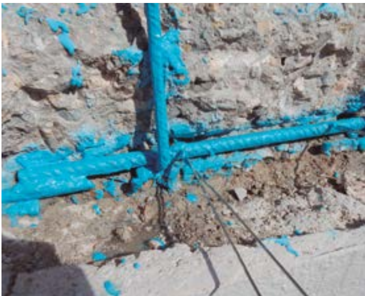
Fig 4. Fase de protección anticorrosión
