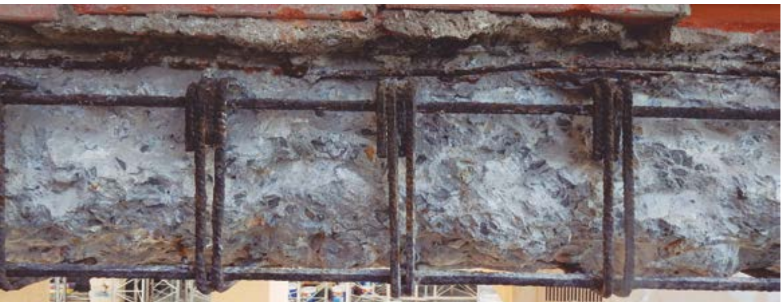
Fig 9. Grado de oxidación medio
