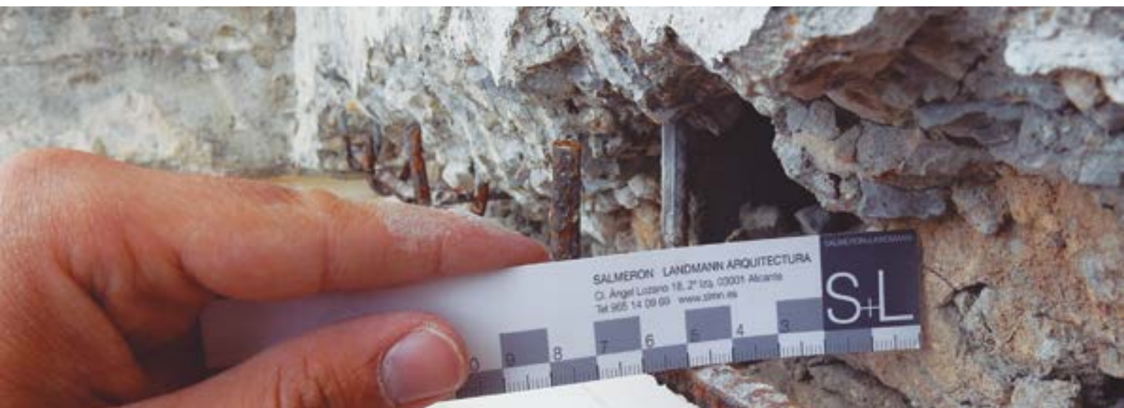
Fig 25. Resultado del picado dejando espacio entre hormigón y armadura
