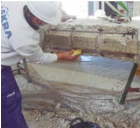
Fig 125. Limpieza de restos de polvo de hormigón
