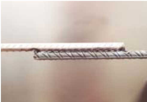
Fig 94. Solape entre armaduras superior a 10 cm
