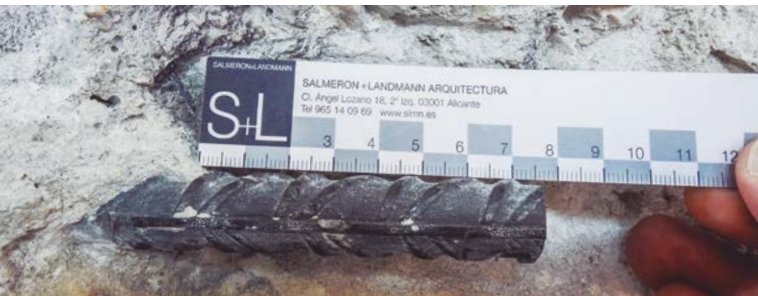
Fig 111. Detalle tramo armadura existente en espera
