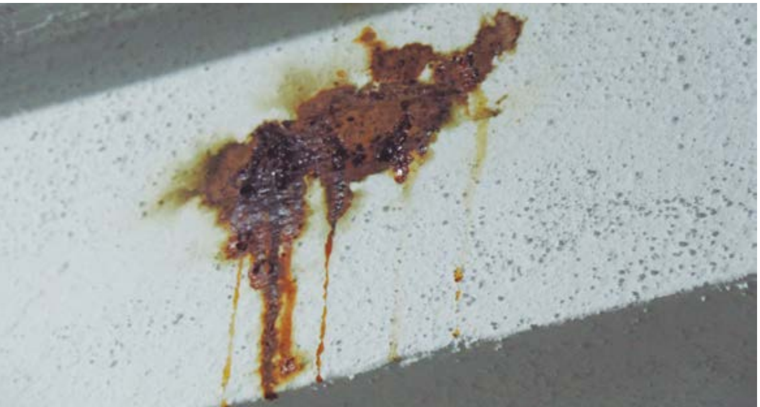
Fig 57. Detalle de migración del óxido
