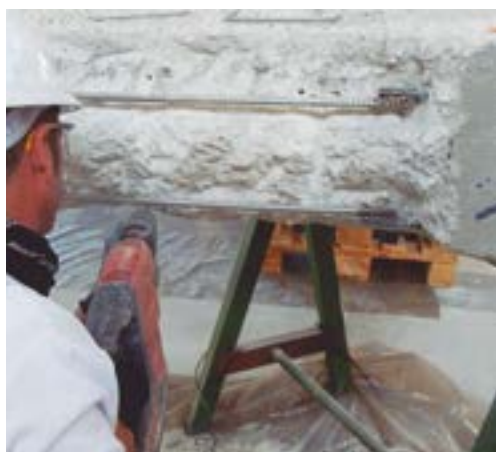
Fig 120. Realización de taladros para la posterior colocación de estribos
