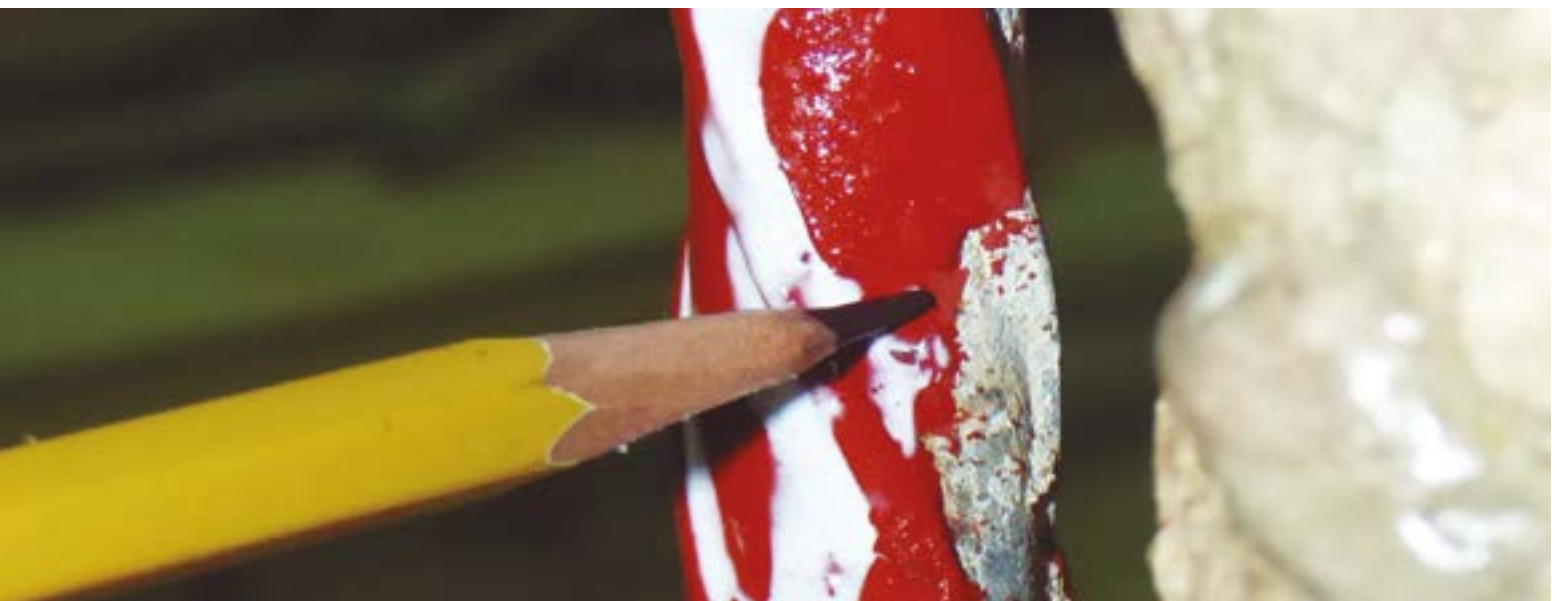
Fig 153. Aplicación de pasivador dejando calvas en la parte trasera de la barra.
