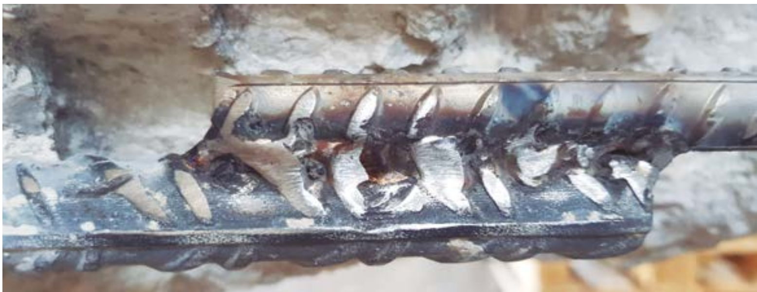
Fig 119. Resultado de cordón de soldadura entre barra nueva y existente, después de la limpieza con piqueta, amoladora y cepillo
