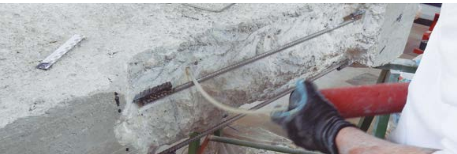
Fig 121. Detalle de soplado de los orificios generados para los estribos
