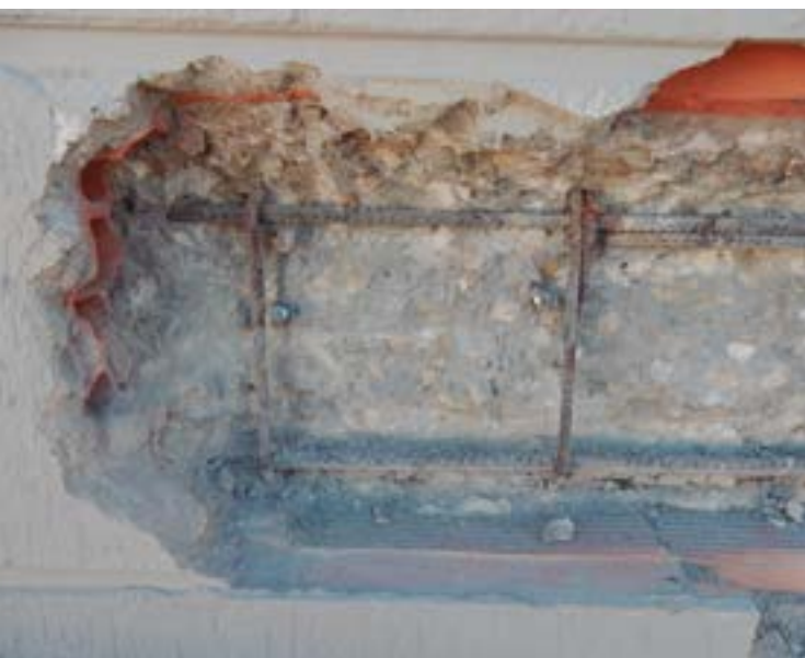
Fig 2. Fase de picado de hormigón en frente de forjado
