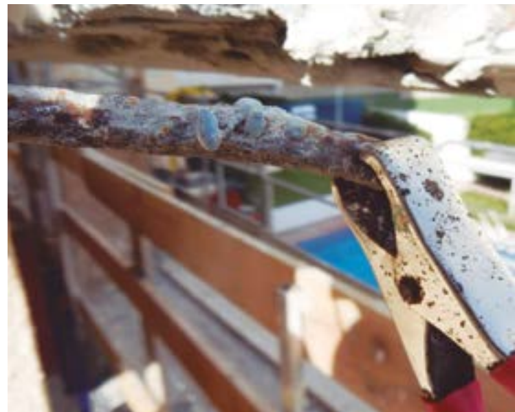
Fig 75. Conexión eléctrica con una barra
