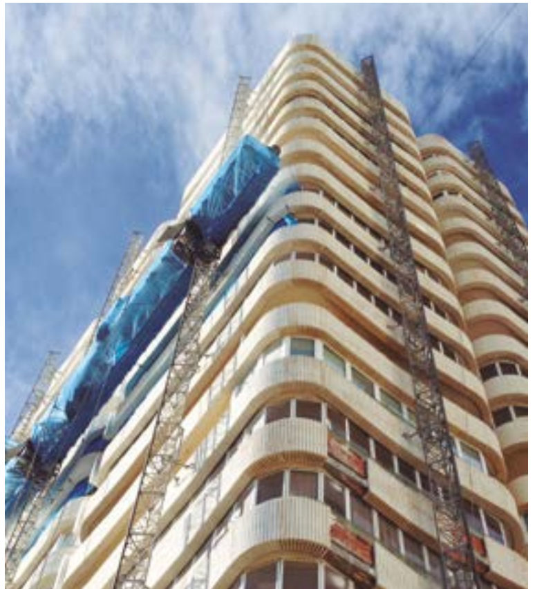
Fig 21. Vista general torre de viviendas con fachada de hormigón prefabricado
