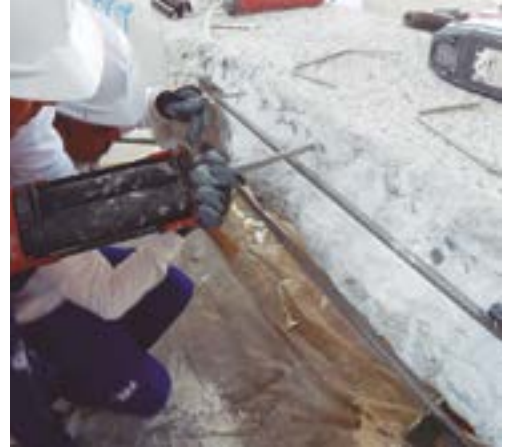
Fig 122. Proceso de inyección de resina epoxi
