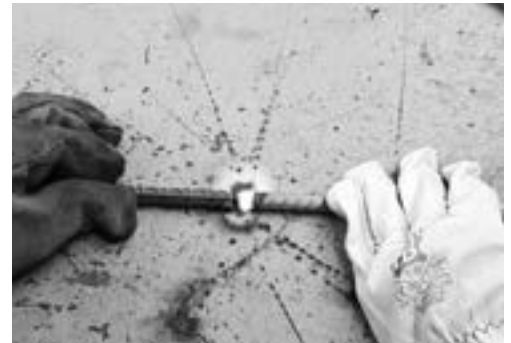
Fig 91. Unión en bisel entre dos armaduras
