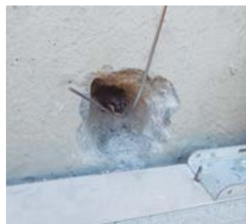
Fig 160. Alambre conectado directamente a armaduras
