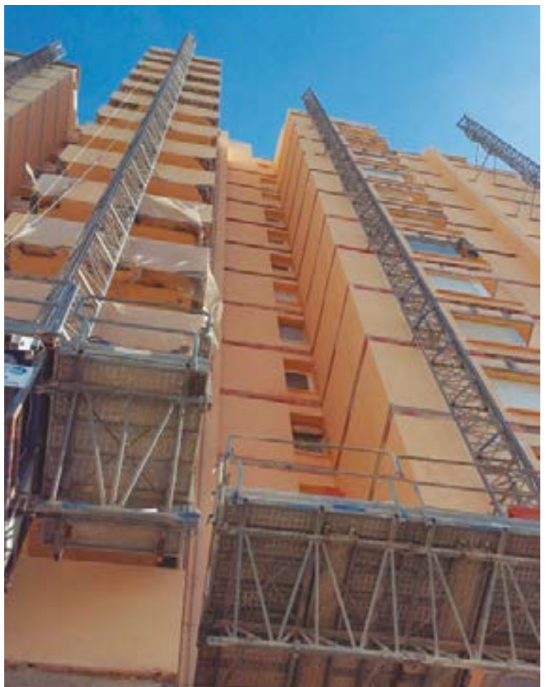
Fig 20. Andamios de cremallera en fachada
