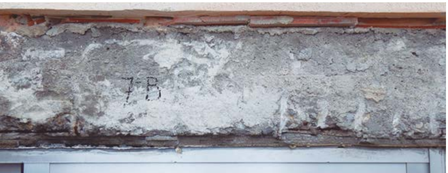
Fig 41. Frente de forjado en edificio de viviendas
