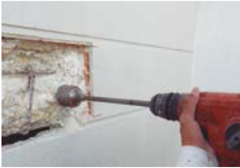
Fig 70. Extracción de testigo en frente de forjado
