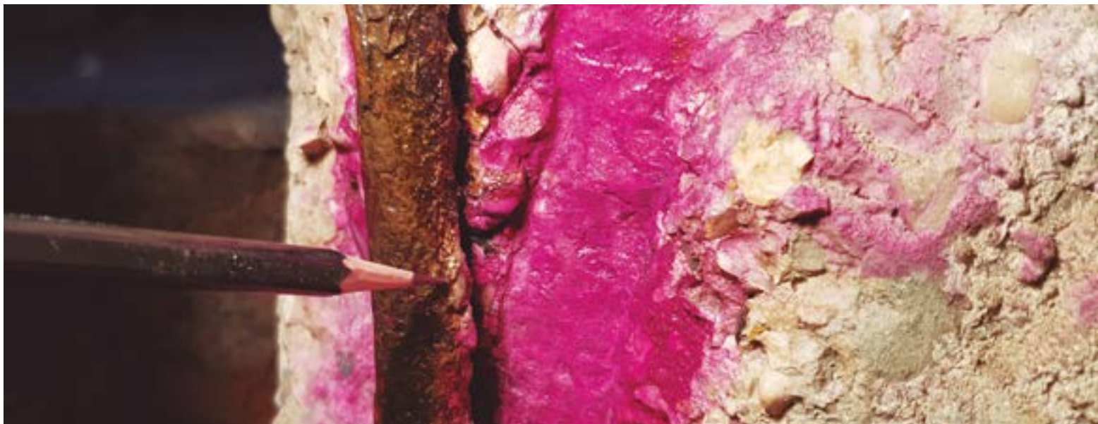
Fig 150. Zona de difícil acceso para la limpieza por falta de espacio tras el picado
