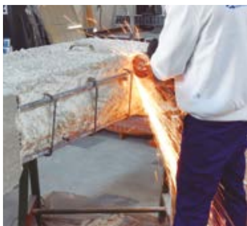
Fig 110. Corte de armadura en proceso de sustitución
