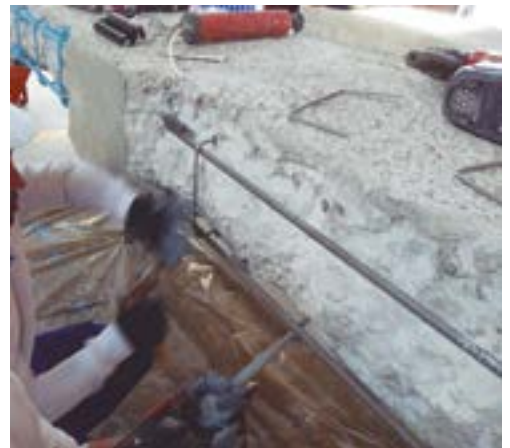
Fig 123. Colocación de estriado para la reconstrucción del armado sustituido
