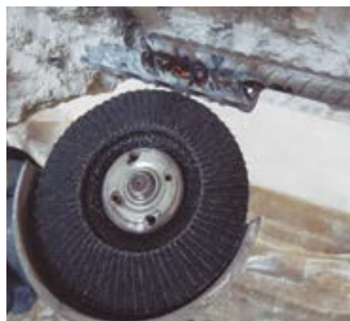
Fig 118. Proceso de lijado de la soldadura
