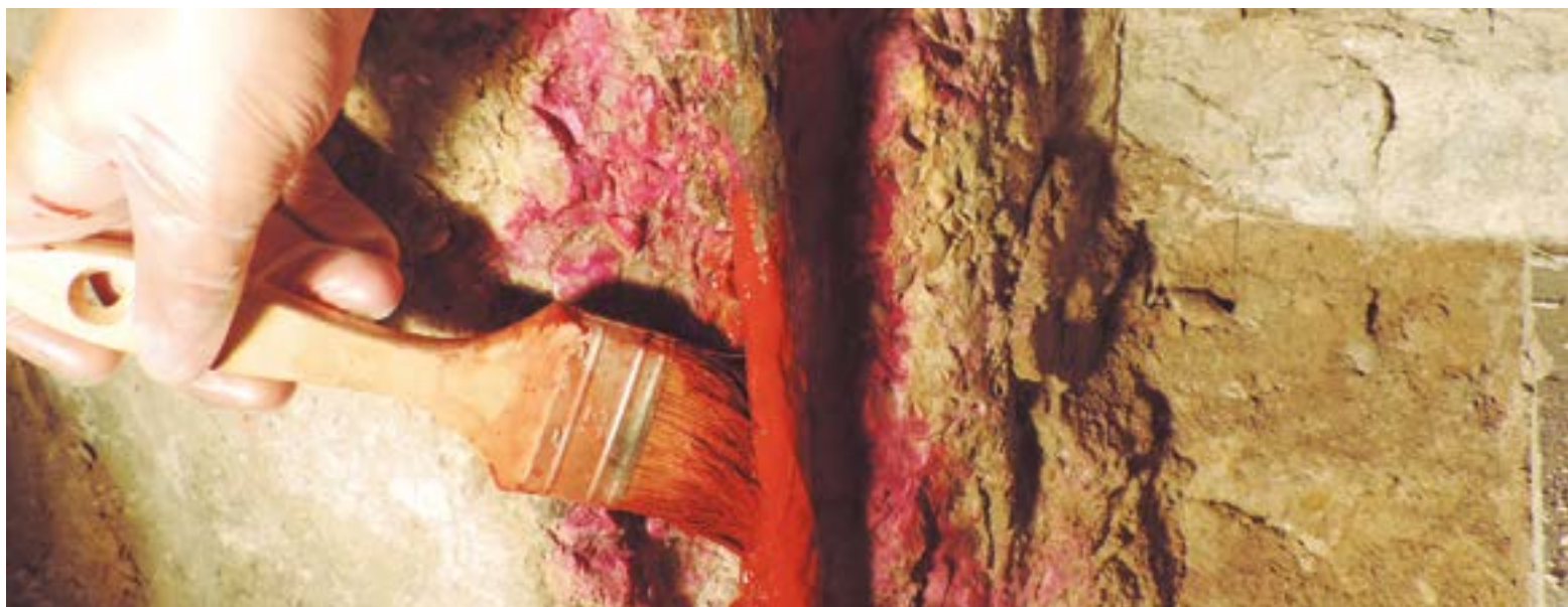
Fig 152. Aplicación del pasivador sobre una barra que no ha sido limpiada.
