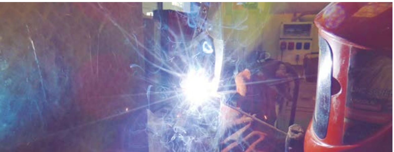
Fig 90. Soldador especializado realizando una soldadura con los medios de seguridad requeridos
