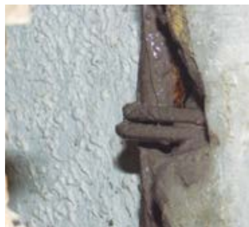
Fig 155. Detalle donde se ha aplicado el puente de adherencia sobre una barra con restos de corrosión.
