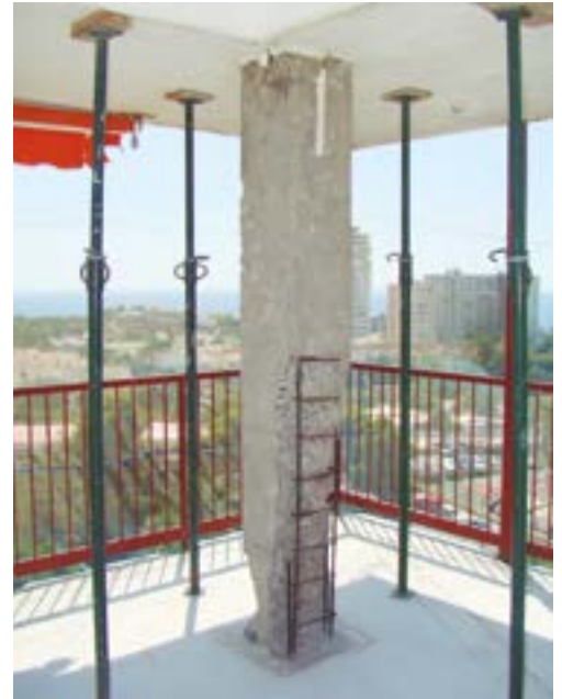
Fig 23. Pilar exento objeto de reparación en planta 18
