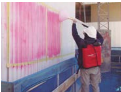
Fig 102. Aplicación de inhibidor
