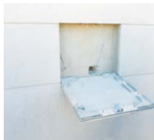
Fig 159. Registro en fachada para control de armaduras de frente de forjado
