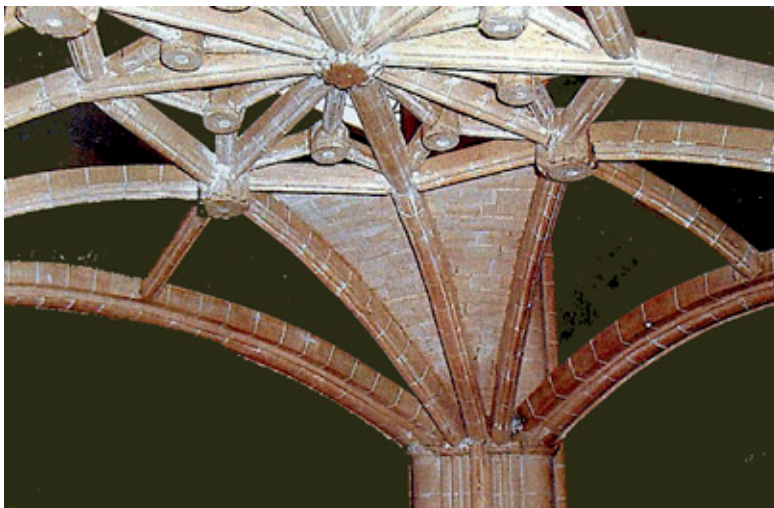
Maqueta de las nervaduras del coro de la iglesia arciprestal de Morella.
