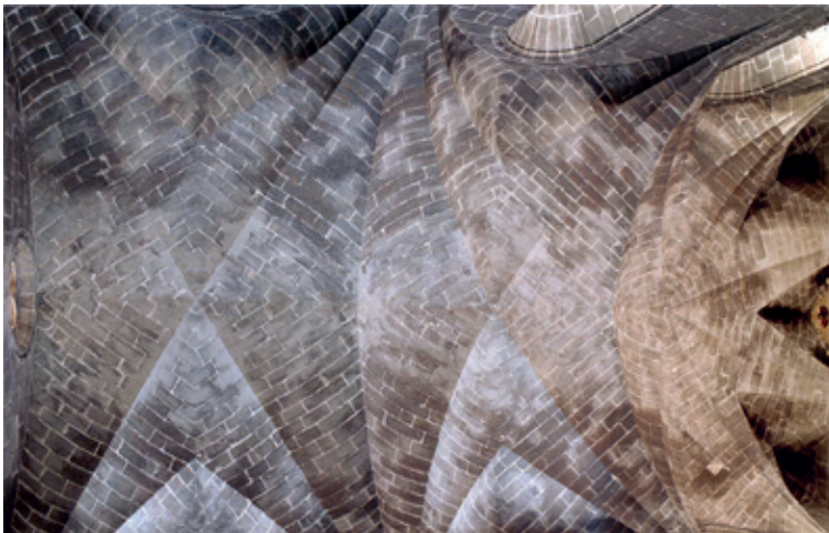
Bóveda aristada de la capilla real del antiguo convento de Santo Domingo de Valencia.
