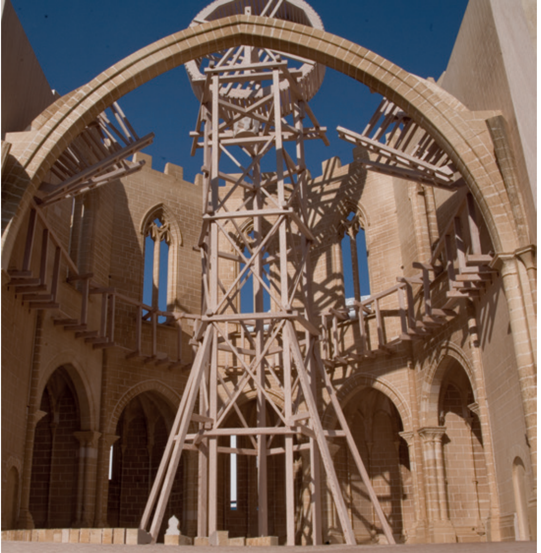
Ábside de la iglesia del Salvador de Burriana (Castellón) en construcción.
