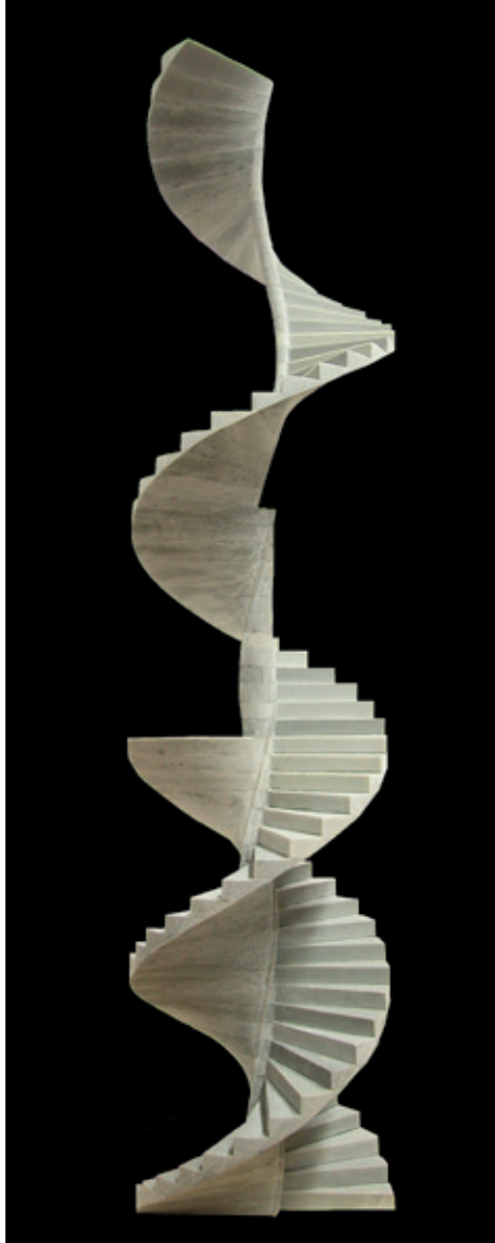
Maqueta de la escalera de doble espiral y caracol de ojo abierto de la capilla real del antiguo convento de Santo Domingo de Valencia.
