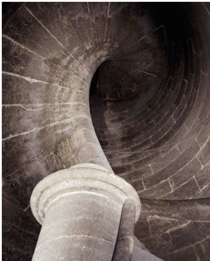
Fotografía del último cuerpo de la escalera de doble espiral y caracol de ojo abierto de la capilla real del antiguo convento de Santo Domingo de Valencia.
