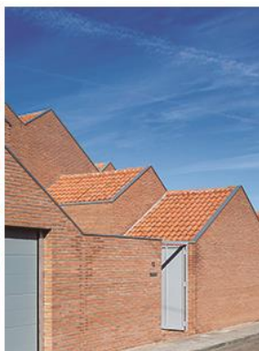
Cubiertas microventiladas de teja cerámica
